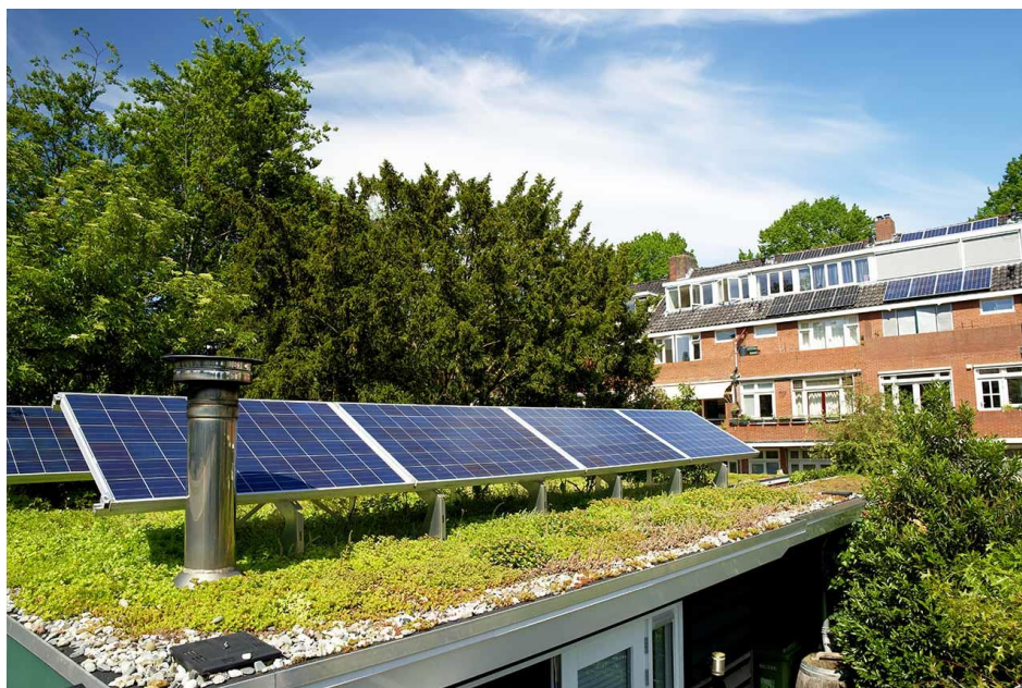
Figuur 17 Groendak met zonnepanelen. Bron: American Organic Energy
