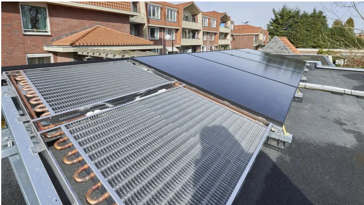
Figuur 20 Inblik in een 420W PV/T-paneel Volthera EVO 2023. Bron: Solar Magazine
