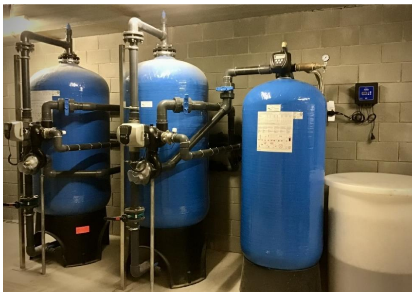
Figuur 8 Filtering regenwater cultuurcentrum Deinze. Bron: Waterdoctor.be
