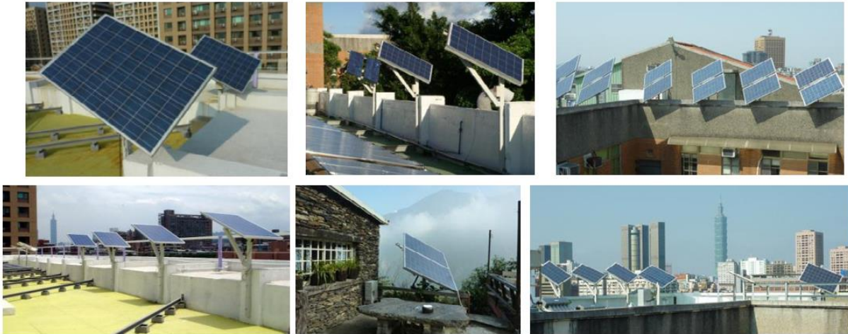
Figuur 22 Testen met éénassig systeem en 3 automatische vaste posities. Bron: Huang, 2013
