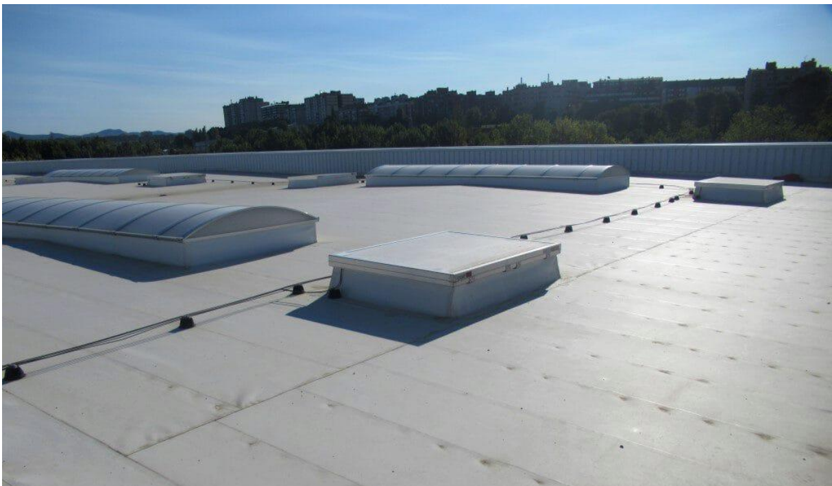
Figuur 15 Spaans dak met mechanische bevestigde meerlaagse TPO bedekking op een stalen ondergrond sinds 1999. Nog steeds performant na meer dan 20 jaar. Bron: holcimelevate.com
