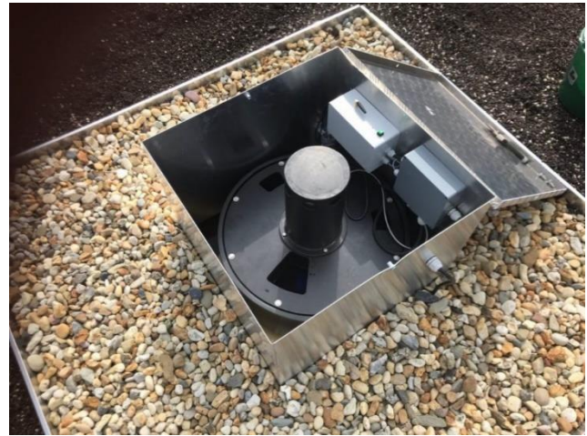
Figuur 12 Dynamisch Waterdak met sturing. Bron: Bouwwereld.nl
